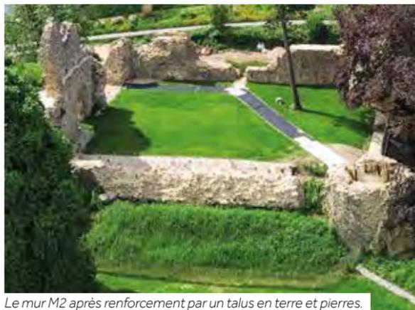
Le mur M2 après renforcement par un talus en terre et pierres. Le chantier s'est déroulé sous surveillance archéologique, conformément à des prescriptions techniques précises, notamment concernant le choix des mortiers.
