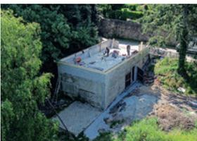
Le chantier a démarré ce printemps pour être achevé en septembre prochain. Les travaux de curage du bâtiment ont été réalisés en interne par les services techniques. L'arasement de l'étage du bâtiment est en cours de finalisation. Les étapes à venir
