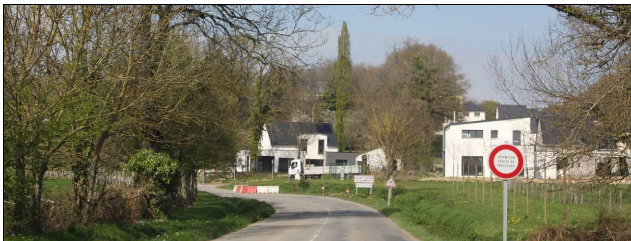
Impact paysager important de la nouvelle opération de lotissement en cours.
